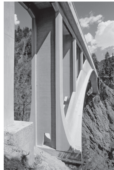
Die Einstiegsöffnungen beim westlichen Bogenwiderlager führen in den geschlossenen Hohlkasten.
