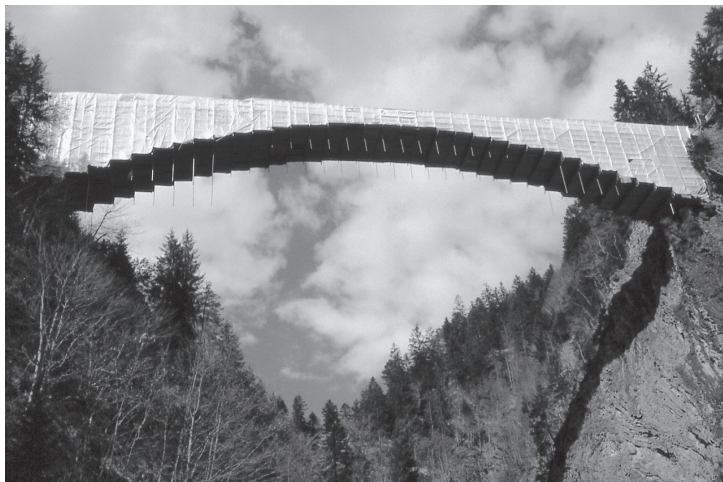
Die eingehauste Salginatobelbrücke während der Instandsetzung von 1997/98
