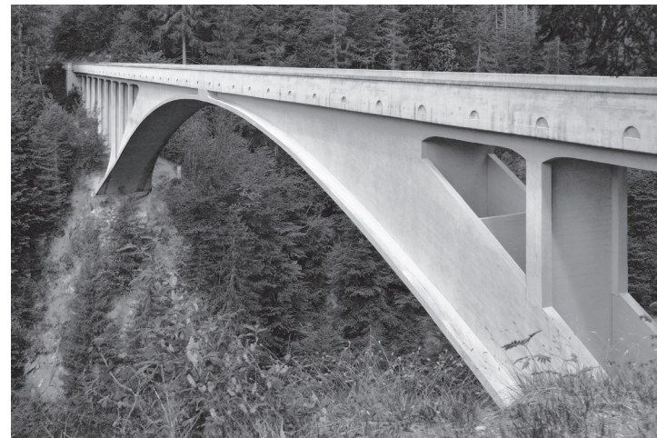
Das monolithische Tragwerk der Salginatobelbrücke: Bogenplatte, Seitenwände und Fahrbahn bilden statisch eine Einheit.
